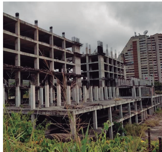
Estado actual del Cardiológico de Montalbán
